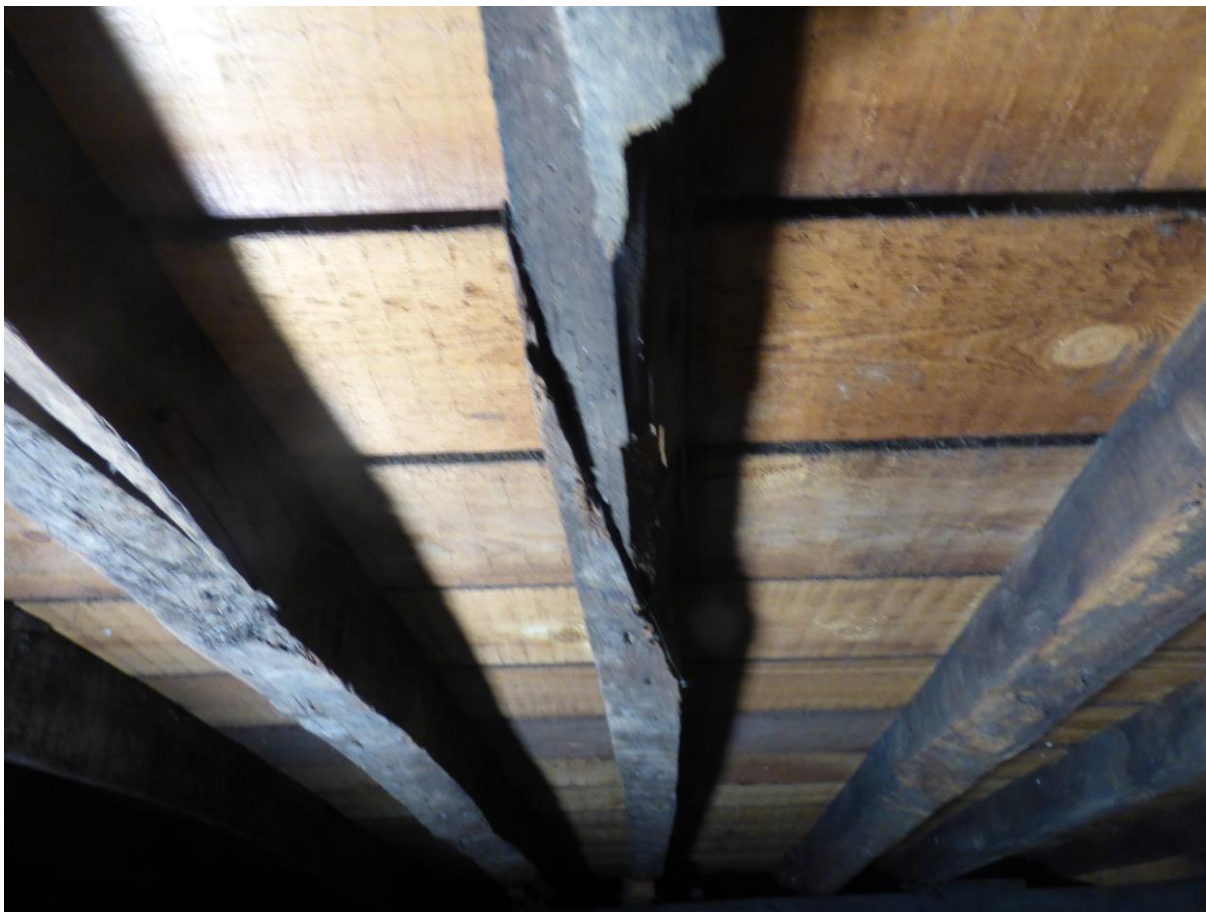
Chevrons présentant des anomalies (à remplacer ou à renforcer) zone B
