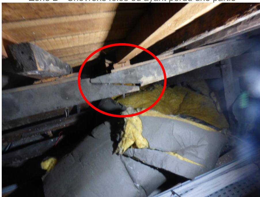
Zone B - Assemblage défectueux
