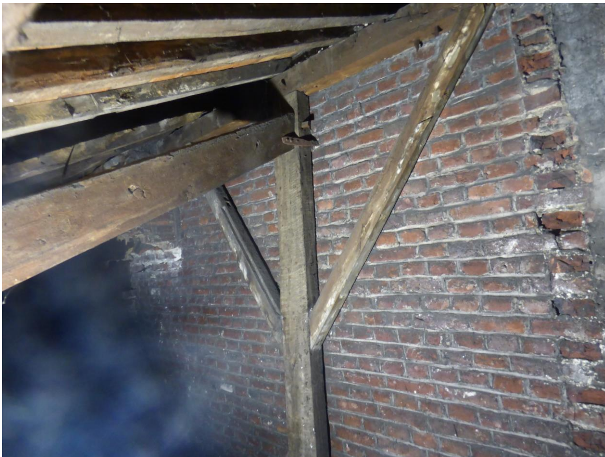
Appui droit des porteurs principaux de la zone B
